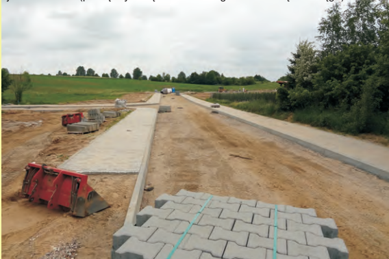
Fragment inwestycji dotyczącej uzbrojenia terenów pod budownictwo jednorodzinne (pomiędzy ulicą Wróblewskiego i Krańcową w Morągu)
