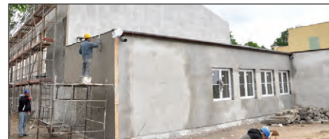
Budowa sali gimnastycznej przy ZS w Księżym Dworze
