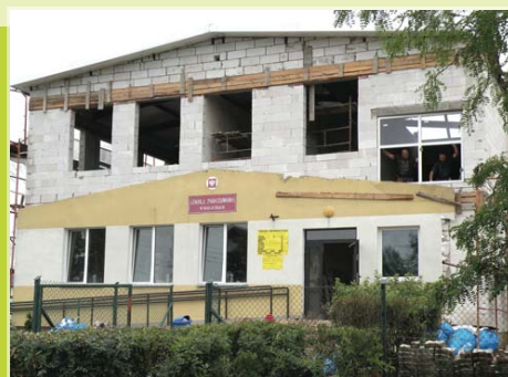
Budowa przedszkola samorządowego w Wieliczkach
