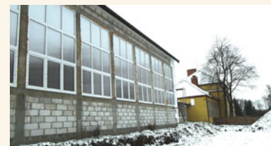
Trwa budowa sali gimnastycznej przy ZS w Malinowie
