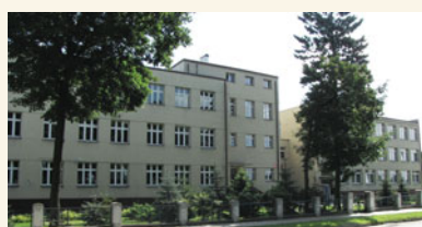
Rozpoczęto budowę sali gimnastycznej przy ZS nr 1 w Działdowie
