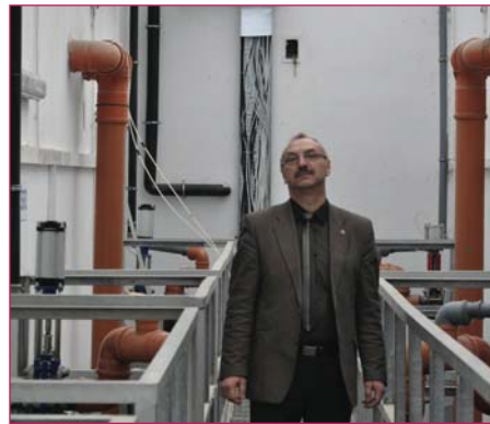
Rozbudowa oczyszczalni ścieków w Rybnie
