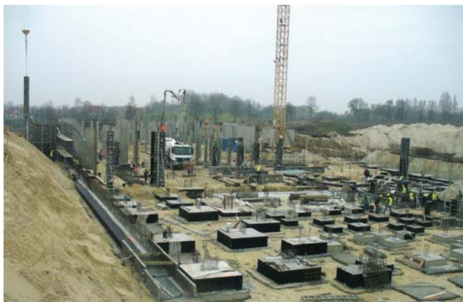
Trwają intensywne prace nad budową Term Warmińskich.
