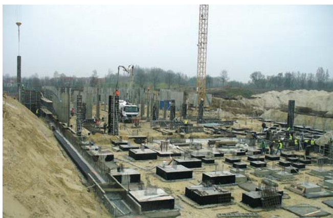
Trwają intensywne prace nad budową Term Warmińskich.
