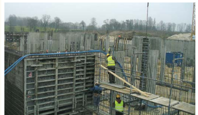
Zakończono stan surowy budynku kotłowni. Aktualnie prowadzone są roboty ziemne pod wioskę wakacyjną.
