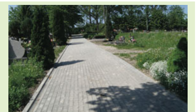
Remont wjazdu i alejki na cmentarzu komunalnym w Młynarach
