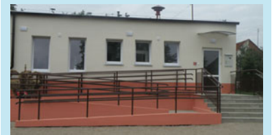
Remont i rozbudowa świetlicy wiejskiej we wsi Karszewo
