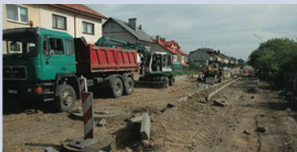
Budowa ul. Polnej
