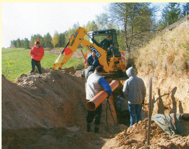
Sieć kanalizacji pokryje znaczną część gminy. Inwestycja ma być zakończona w roku 2013
