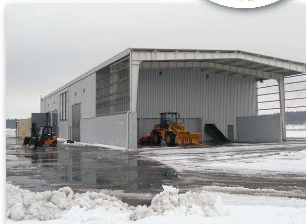
Budynki Zakładu Odpadów Komunalnych: sortownia...
