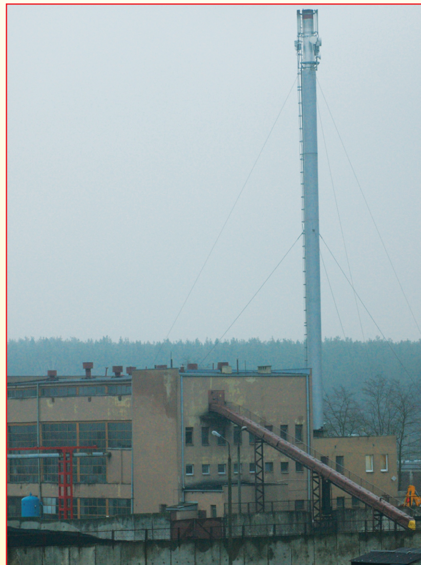
Ciepłownia przy ul. Nidzickiej w Działdowie
