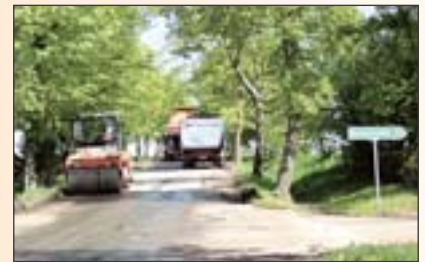
Remont drogi na odcinku Równina Górna – Olszyna o długości 6,5 km. Koszt inwestycji to ponad 3 mln zł. Finansowany ze środków Narodowego Programu Budowy Dróg Lokalnych, Gminy Korsze i Starostwa Powiatowego w Kętrzynie.
