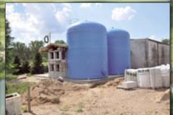
Rozbudowa oczyszczalni ścieków
