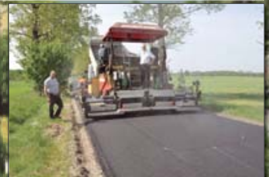
Budowa dróg gminnych
