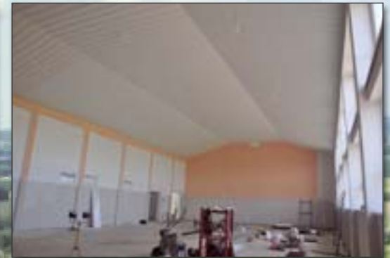
Budowa sali gimnastycznej przy SP w Rybnie
