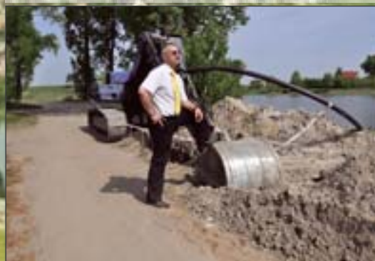
Rozbudowa kanalizacji w Tuczki-Żabiny
