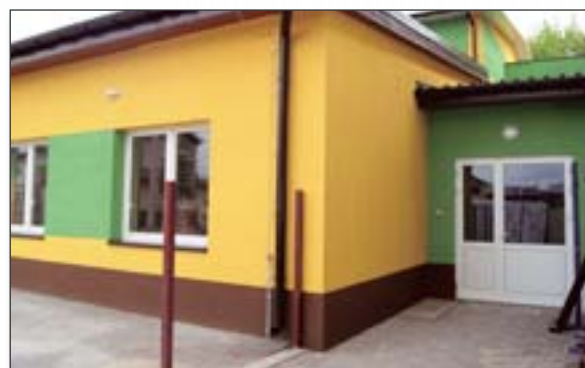
Dobiega końca budowa sali gimnastycznej przy ZS w Lidzbarku
