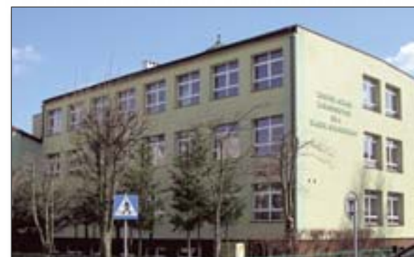
ZZS nr 1 w Działdowie po termomodernizacji
