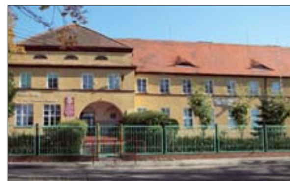
W ZS w Malinowie trwa modernizacja i doposażanie pracowni
