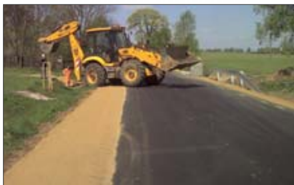
Przebudowa drogi powiatowej Uzdowo - Kramarzewo
