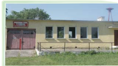
Świetlica w Karszewie przed remontem.
