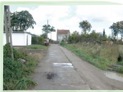
Droga przed przebudową
