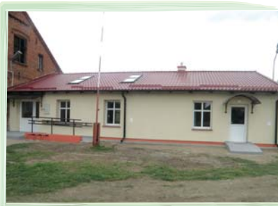
Budynek jak nowy - świetlica w Błudowie po remoncie
