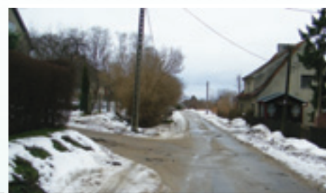
Ulica Reymonta w Kętrzynie czeka na modernizację. Dokumentacja na przebudowę będzie gotowa jeszcze w tym roku
