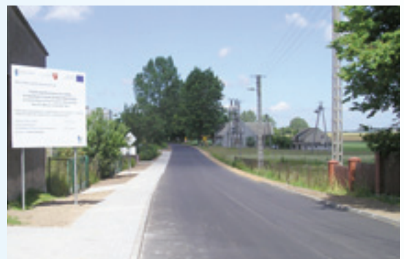
Zakończony I etap przebudowy drogi powiatowej Dębien - Truszczyń
